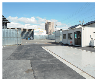
スクラップヤードの設計・施工
